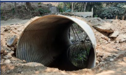
Construcción de bóveda en la quebrada a la altura del caserío Santa Lucía
