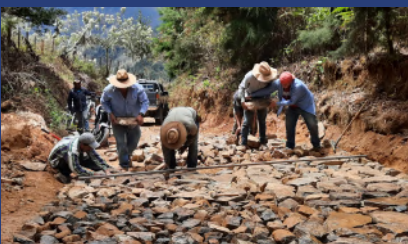
Pavimento en la subida al caserío Plan Grande
