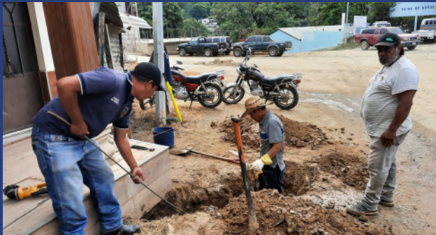
Reparación, limpieza y mantenimiento de tubería de drenaje en: barrio El Tamarindo, caseríos Linda Vista, Trapiche Viejo y El Común.
