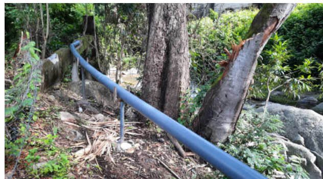
Ampliación y mejoramiento del proyecto de agua del caserío Linda Vista, el cual beneficia a 228 familias.
