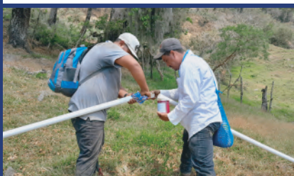
Introducción de tubería de agua potable desde El Güitón hasta Santa Lucía y ampliación de la red de distribución
