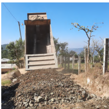
Reposición de material balasto
