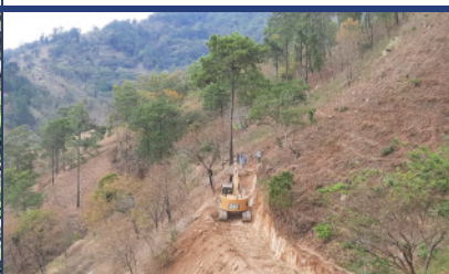
Introducción de carretera que unirá el caserío San Isidro con la Aldea La Concepción
